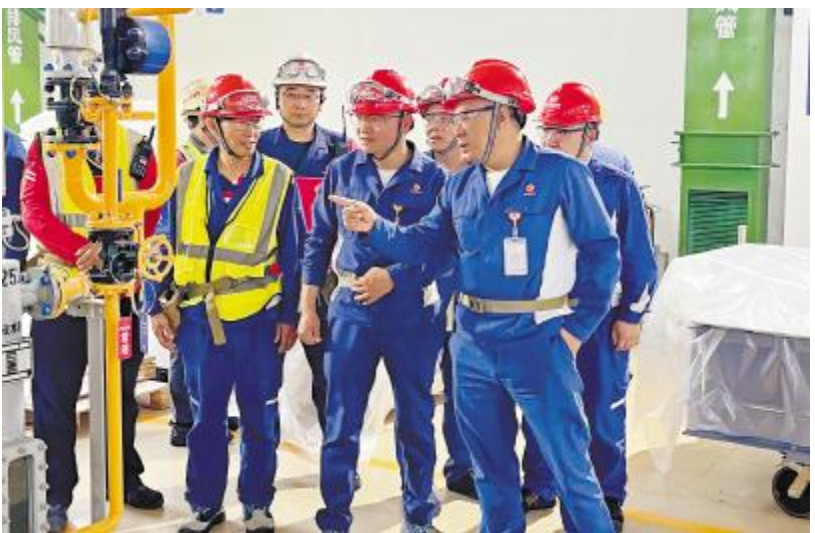
云南通威二期氯碱全系统一次性开车前检查现场
