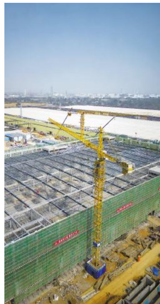
2024年2月,通威太阳能眉山基地四期项目进行结构封顶钢架搭建
