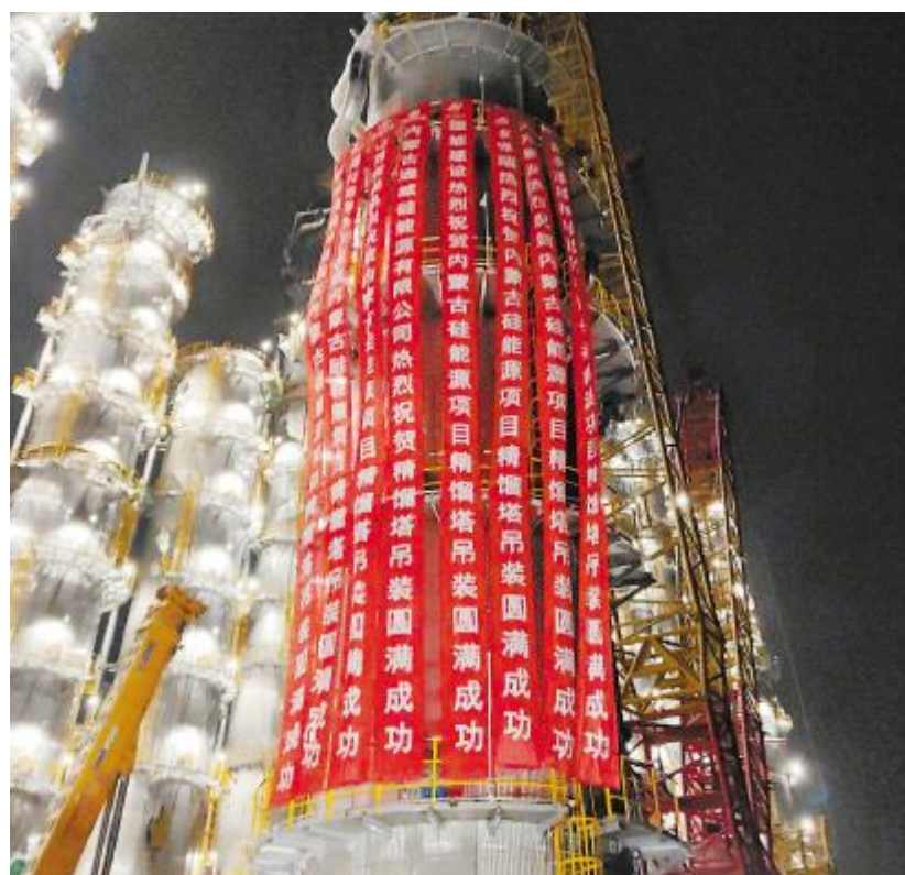
内蒙古通威硅能源精馏塔吊装圆满成功
