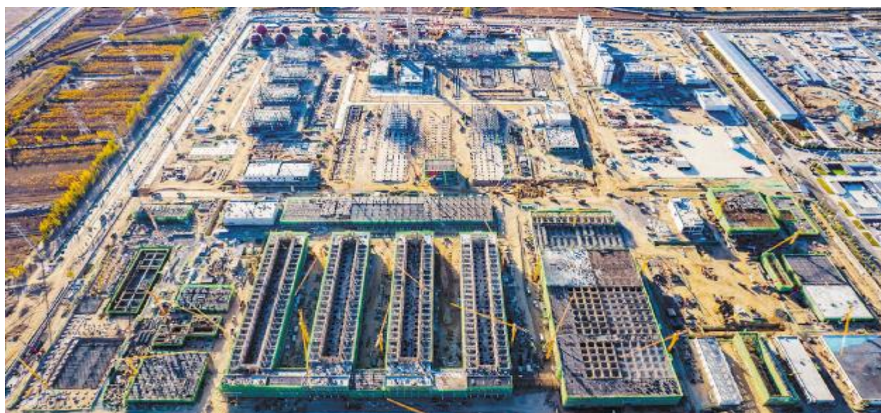
内蒙古通威硅能源项目高效推进
