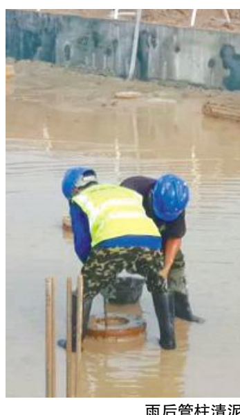
雨后管柱清理
