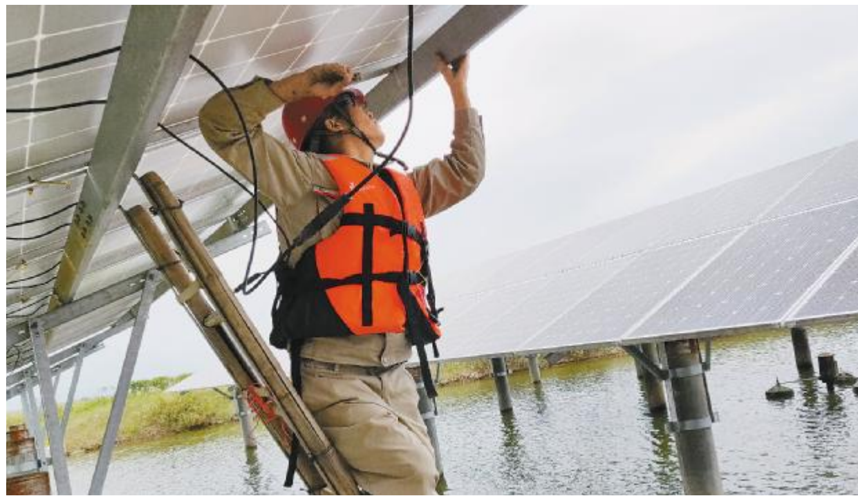
广东台山电站开展雨季防风隐患排查
