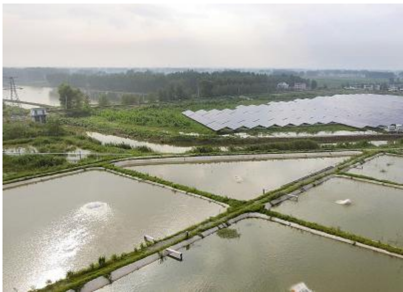
南京龙袍“渔光一体”项目生态湿地所在区域
