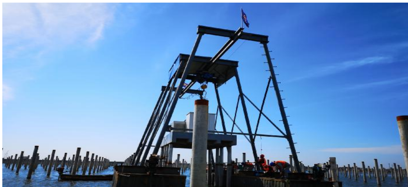
通威新能源不断优化技术方案,全力推进光伏电站建设
