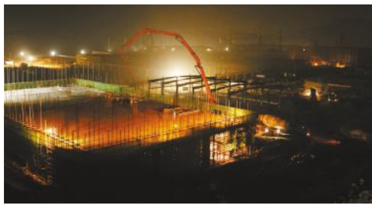
夜间施工有序进行
