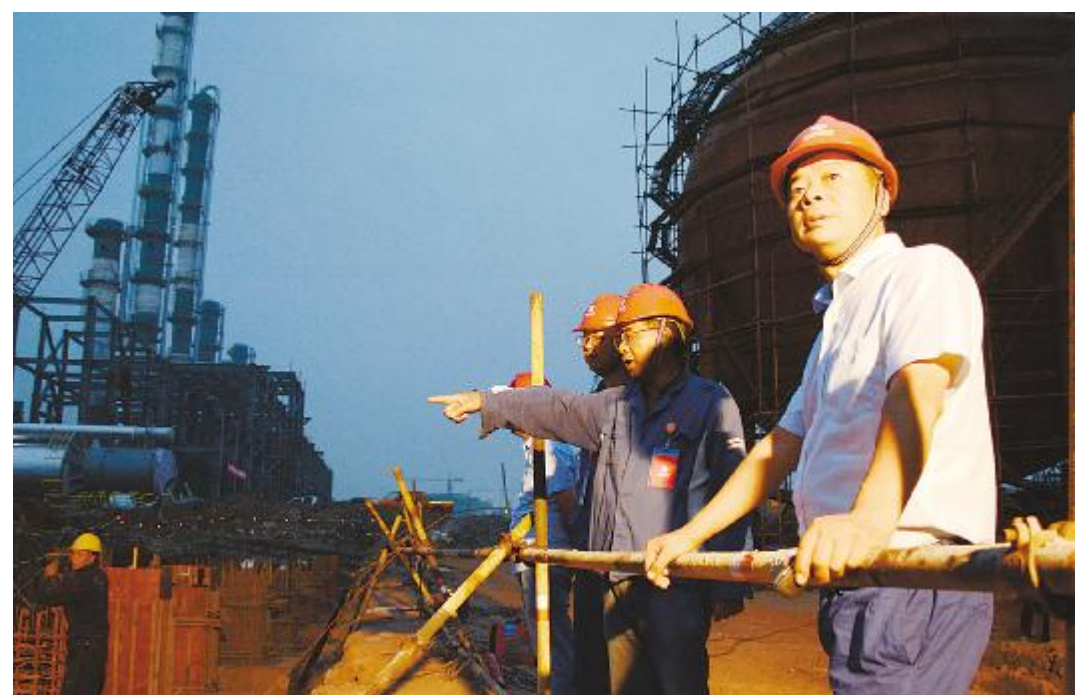
傍晚,永祥新能源工程部负责人还在进行管廊基础施工检查
