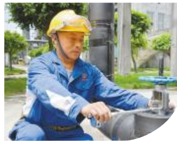
李盛国在测量法兰尺寸
